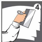
**4** Нанесите шпатлевку на поверхность, оклеенную стеклохолстом, металлическим шпателем или кельмой слоем от 0,1 до 2 мм. Время высыхания между слоями 2 часа. Шлифование финишного слоя рекомендуется производить через 2-4 часа после нанесения. Время полного высыхания 24 часа. По окончании работы инструменты промойте водой. Дальнейшие отделочные работы можно проводить после полного высыхания шпатлевки.
