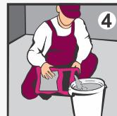
Для подготовки раствора залейте водопроводную воду комнатной температуры в чистую ёмкость из расчёта 5,0-6,0 л воды на 1 мешок (25кг).
