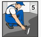
Раствор разлейте на поверхности по маякам, установленным параллельно друг другу на расстоянии на 15-20% меньшем длины правила, и распределите широким правилом. При слое меньше 10 мм установка маяков не требуется. Выравнивание поверхности производите за один прием, без перерывов.
